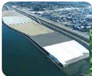
施工完了現場
