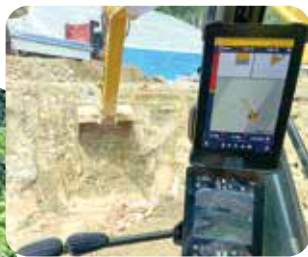
ICT 重機による施工
