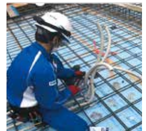
建物電気配線工事
