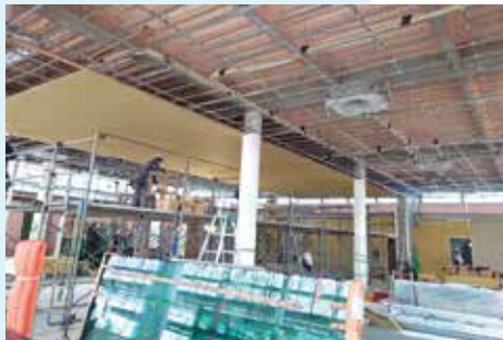
施工中の様子
