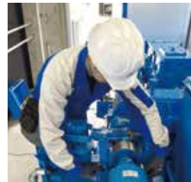
回転機器の分解点検作業
