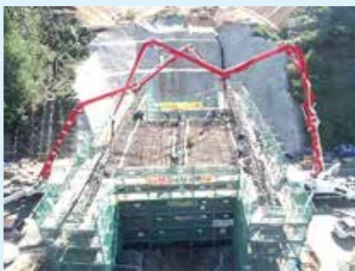
工事現場状況
