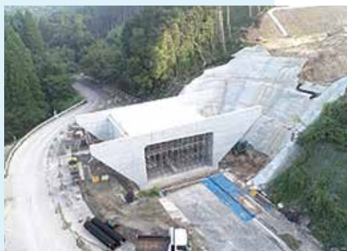
BOXカルポート工事
